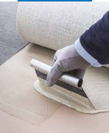
Montering av heltäckningsmatta med baksida av Action Bac®
