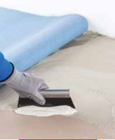
Applicering av Ultrabond Eco TX1
