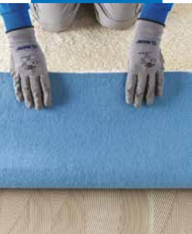
Montering av heltäckningsmatta med filtbaksida
